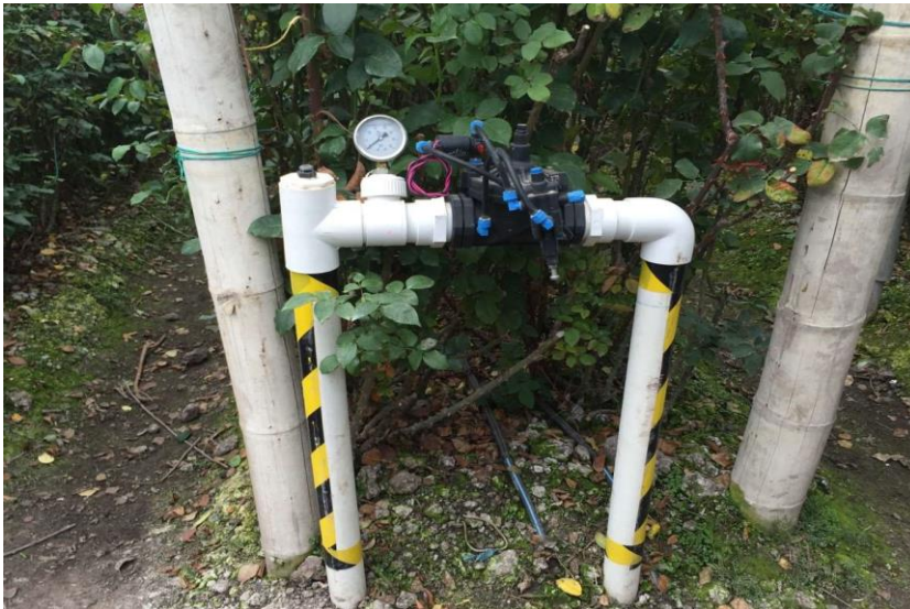
Fig. 4 Cabezal de control para cada sector de riego
